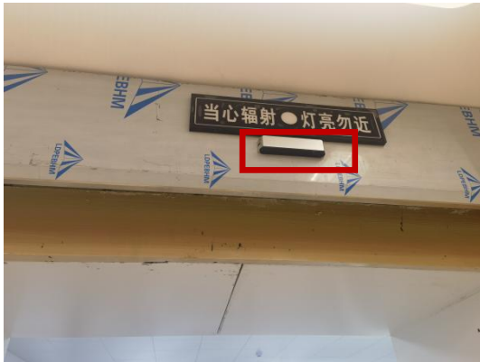
图 2-15 防护门上方红外线防夹装置
