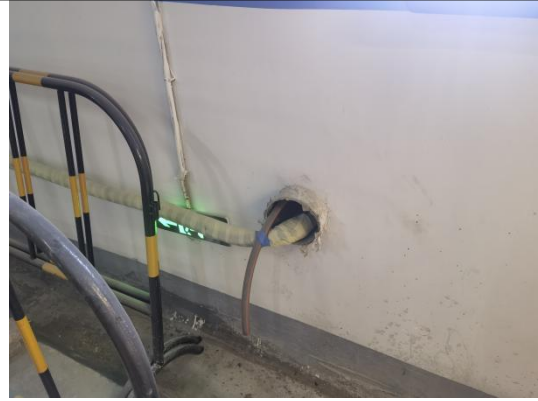
图 2-22 空调电缆及排水管机房外穿墙处
